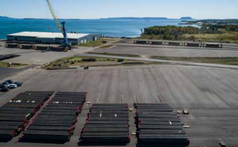
Acier entreposé dans la nouvelle zone de mise en cale asphaltée
